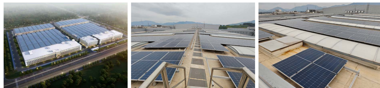
部分投用工厂光伏项目
