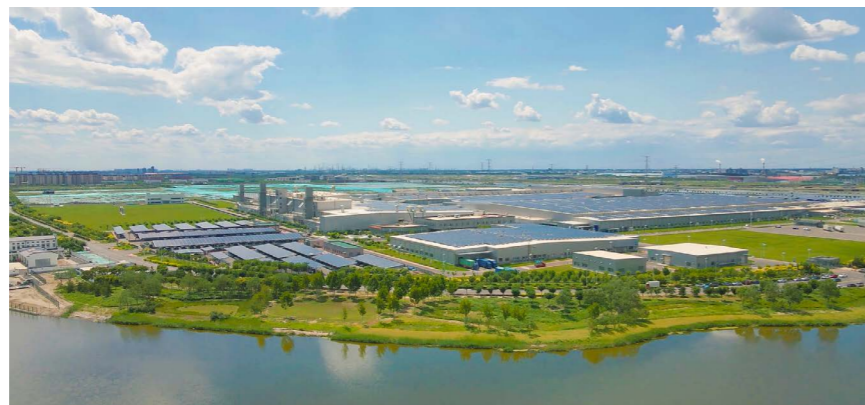
一汽丰田智慧化高效能新能源工厂
